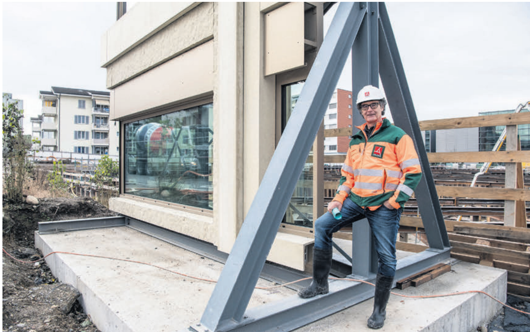
Bauleiter Thomas Stalder von der Anliker AG Generalunternehmung neben der Mock-up-Wand. Diese ist in Absprache mit der Stadt Sursee rund zwei Meter breit, 5,5 Meter lang und mehr als 6 Meter hoch geworden. Sie wird nach den Detailabklärungen in einigen Monaten wieder abgebaut und fachgerecht entsorgt. FOTOS FABIAN ZUMBÜHL
