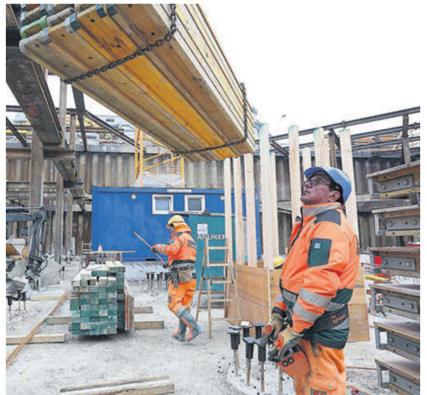
Luis Ruis – als Kranführer am blauen Helm zu erkennen – bediente derweil den kleineren Kran vom Boden aus mittels Fernsteuerung.
